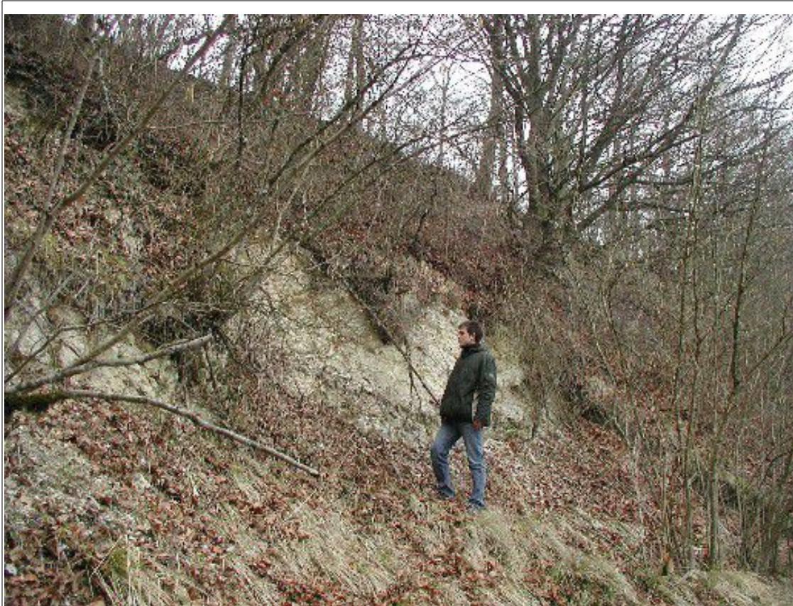
Illustration 8: Escarpement résiduel au sommet du glissement
