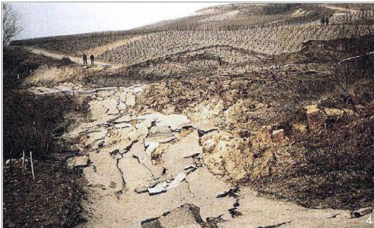
Illustration 10: Destruction de la route lors du glissement en 1988
